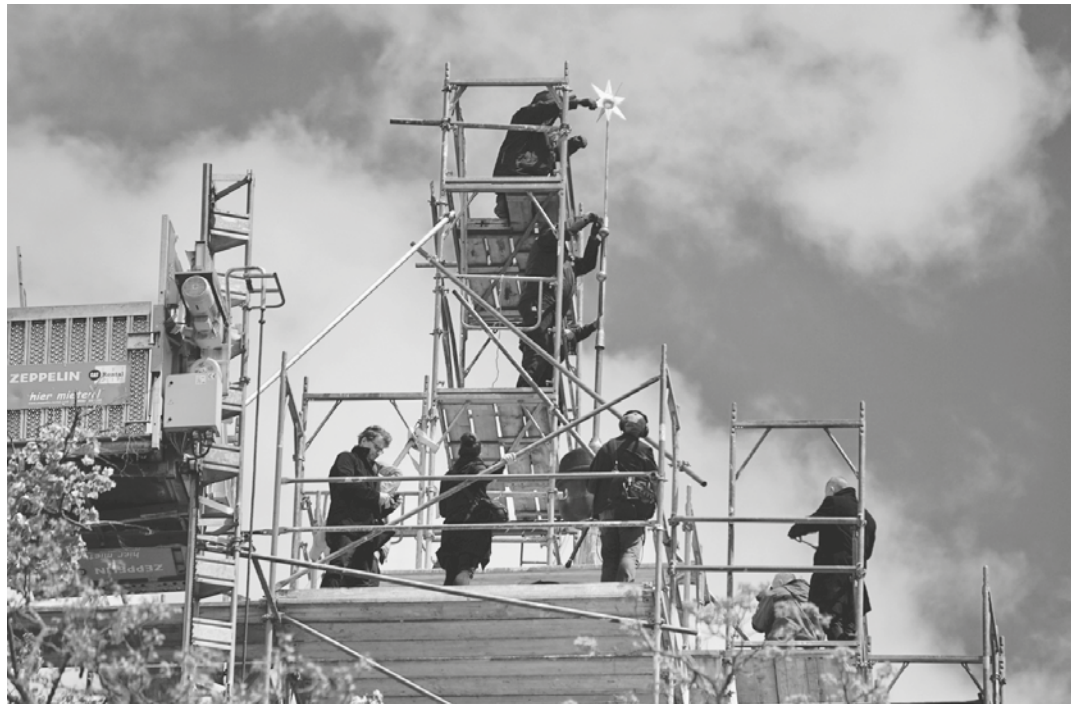
Aufsetzen der Turmbekrönung der Kirche in Greiffenberg
