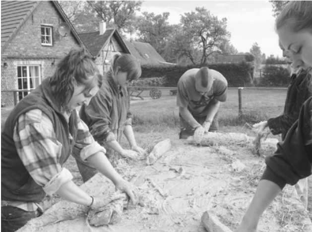
Freiwillige der Jugendbauhütte bei der Herstellung von Lehmwicke Foto: Bernd Henning
