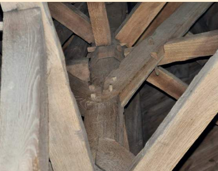
Kaiserstuhl im westlichen Dachstuhl von 1598
