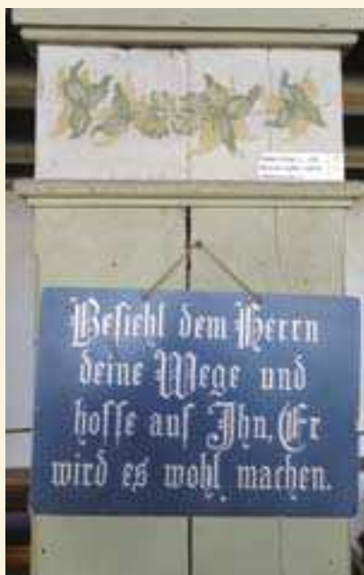
Detail mit restauratorischen Voruntersuchungen
