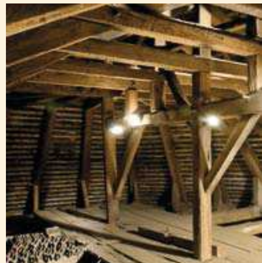
Blick in den Dachstuhl
