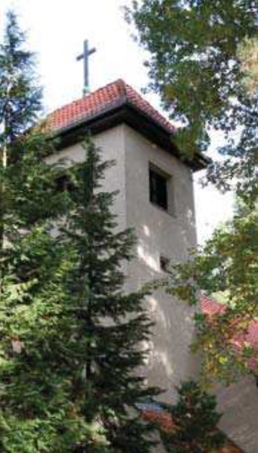
Dorfkirche Bergfelde (Oberhavel) Foto: Werner Rohrer
