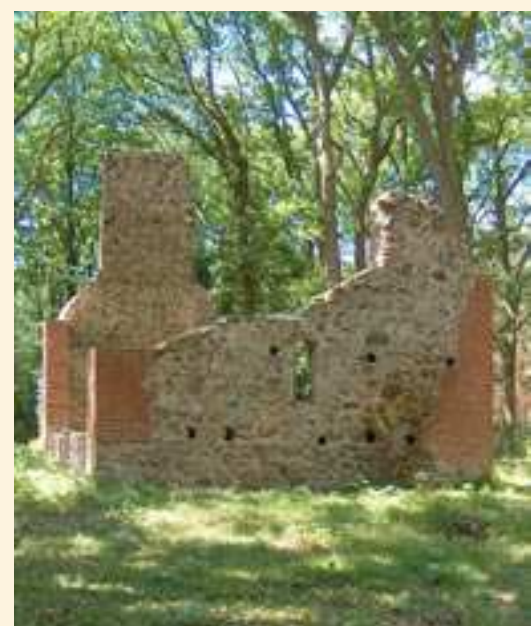
Kirchenruine Dangelsdorf, Foto: Thomas Langer
