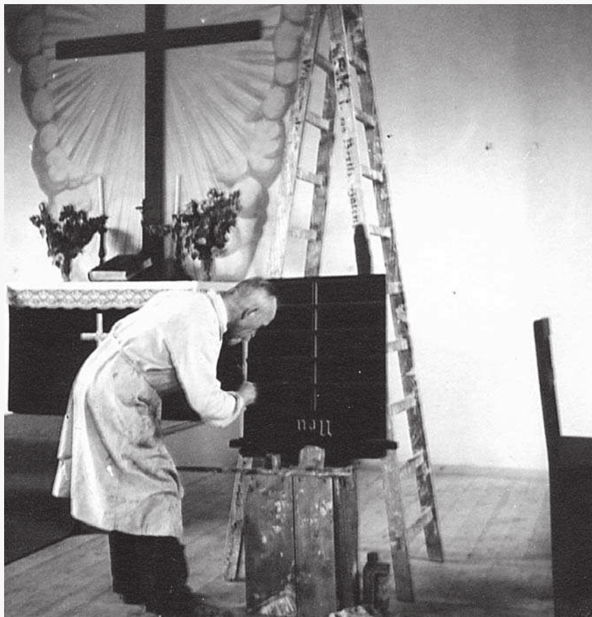
Erich Kistenmacher bei den Abschlussarbeiten an der Wilmersdorfer Kirche; Foto: Anna von Buch, 1936
