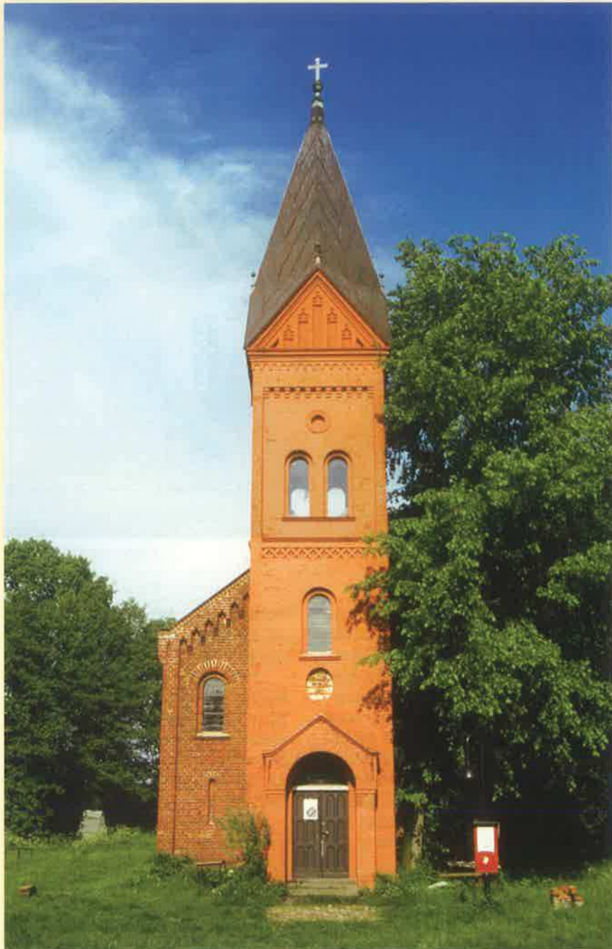
Dorfkirche Messdunk nach der Instandsetzung |
