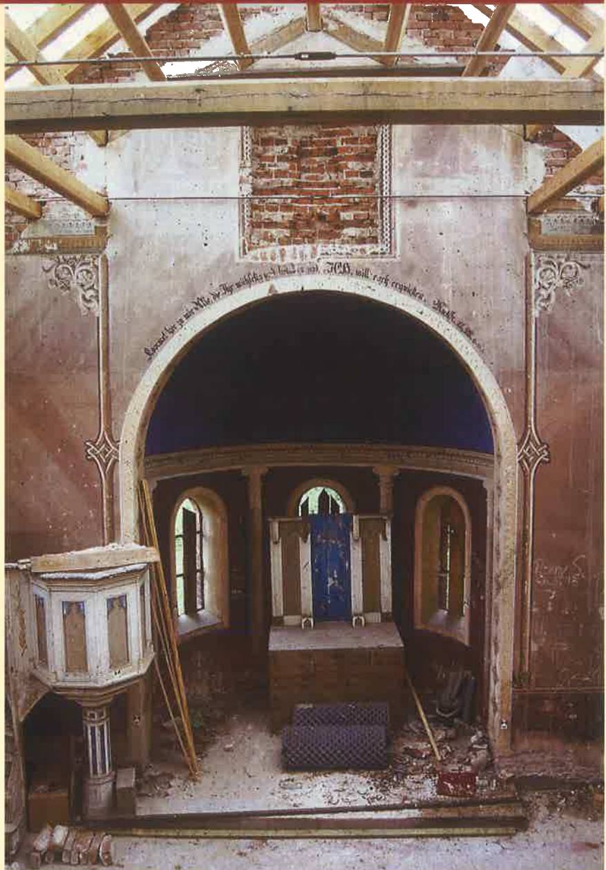
Innenraum der Dorfkirche Messdunk vor der Instandsetzung 1991.
