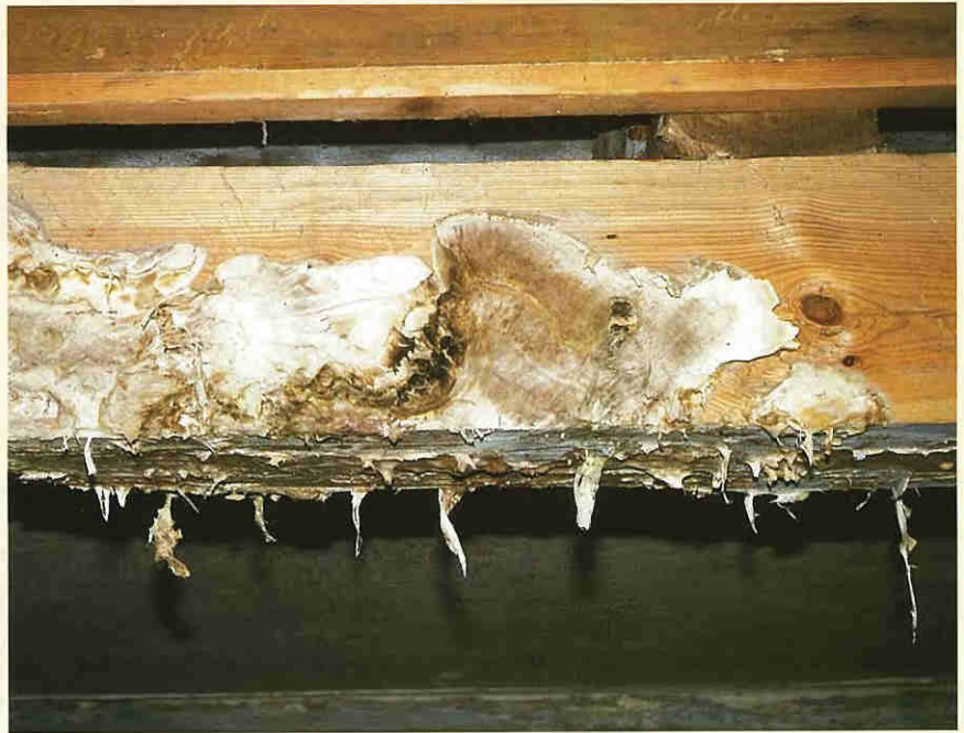
Echter Haußschwamm an der Empore der Dorfkirche in Blindow . |
