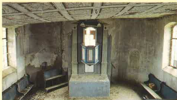
Foto oben: C. Helmcke Unten: Innenraum vor der Instandsetzung, 1997
