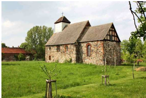
Dorfkirche Lichterfelde vor Beginn der Sanierung; Foto: Hans Krag
