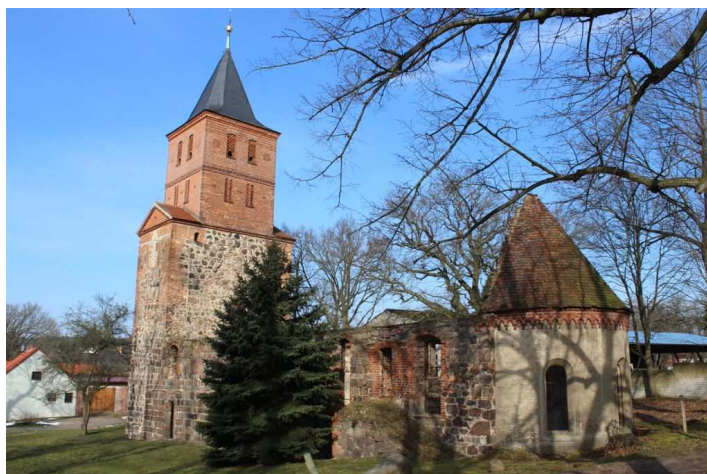
Dorfkirche Rogäsen vor Beginn der Sanierung; Foto: FAK
